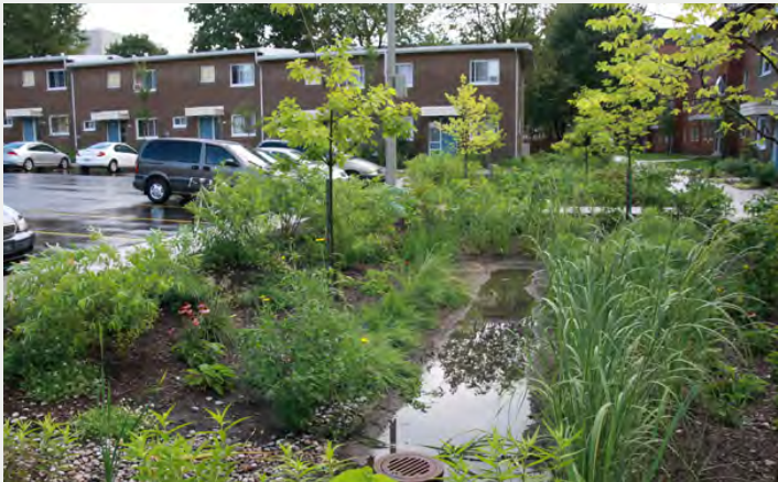
[Bassin de biorétention dans l'un des stationnements des Habitations Jeanne-Mance à Montréal, crédit : Exp]
